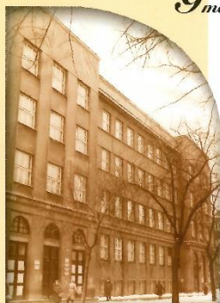
Gmach Głównego Urzędu Statystycznego (lata 1945-1952) Warszawa, ul. Narbutta 33
