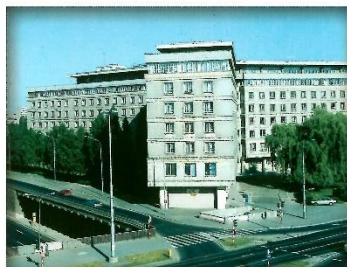
Obecny gmach Głównego Urzędu Statystycznego Warszawa, ul. Niepodległości 208
